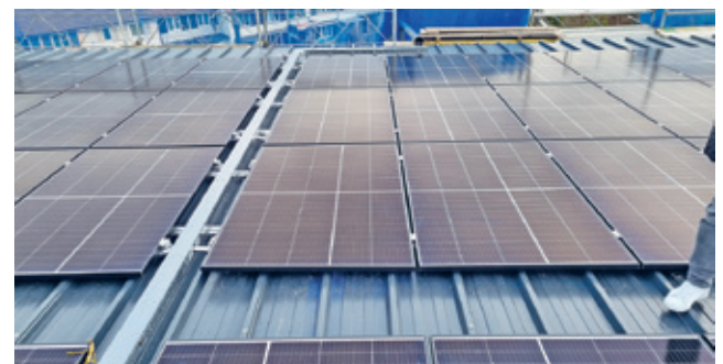
PV-Anlage (Montage der Solarzellen)
